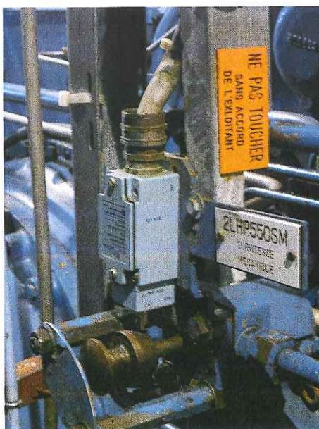
Figure 4 - Signalétique ajoutée au niveau du dispositif de survitesse mécanique
